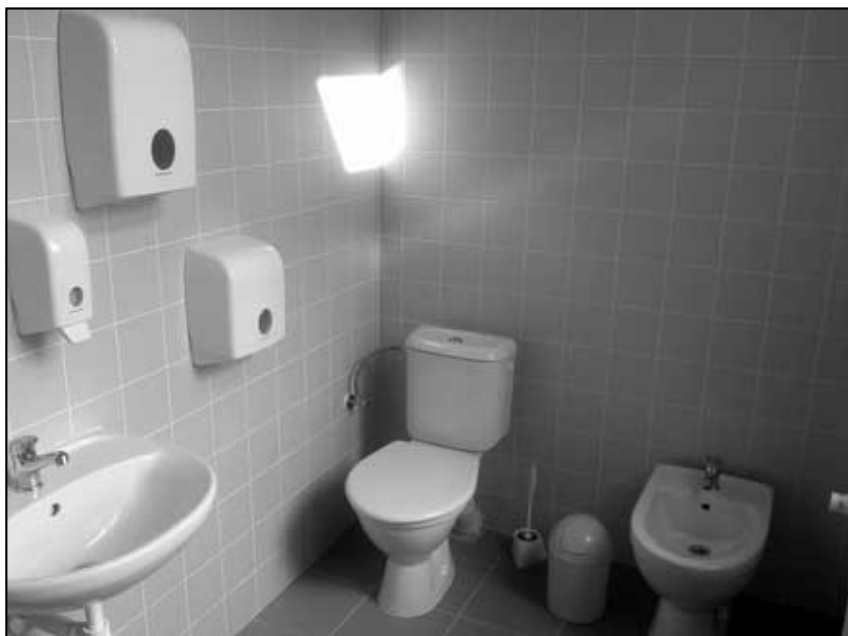
Přestavba sociálního zařízení v dolní budově ZŠ
